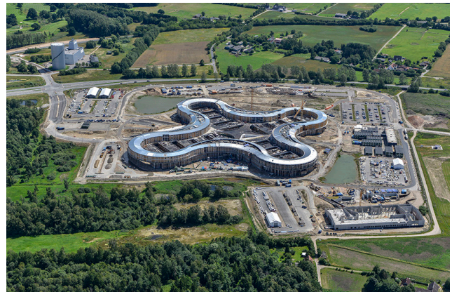
Byggeplads for Nyt Hospital Nordsjælland, juli 2023.
