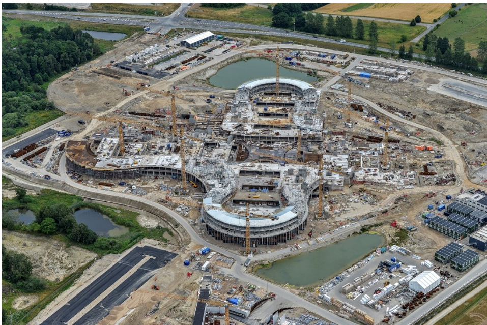
Byggeplads for Nyt Hospital Nordsjælland, juli 2022.
