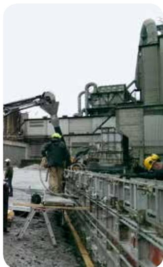
Støbning af betonvæg med fremtidens cement
