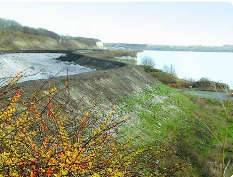
Nyttiggørelse af mikrofiller i voldanlæg ved efterbehandling af kridtgraven
