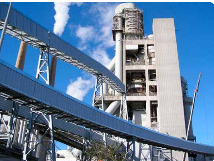
Støjdæmpning af rørbånd til ovn 87 ved afskærmning af transportanlægget
