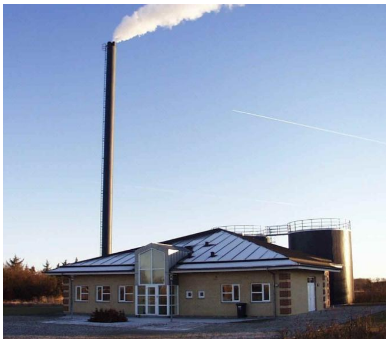
Figur 8-28 Øster Hurup Kraftvarmeværk
