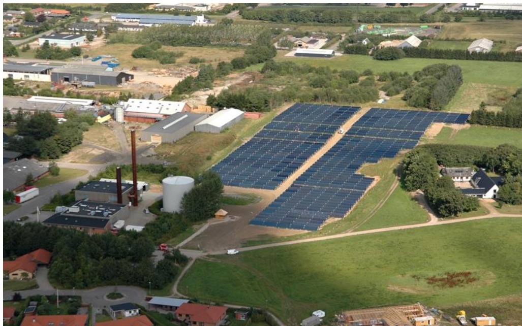
Figur 7-2 Solvarme i Brædstrup
