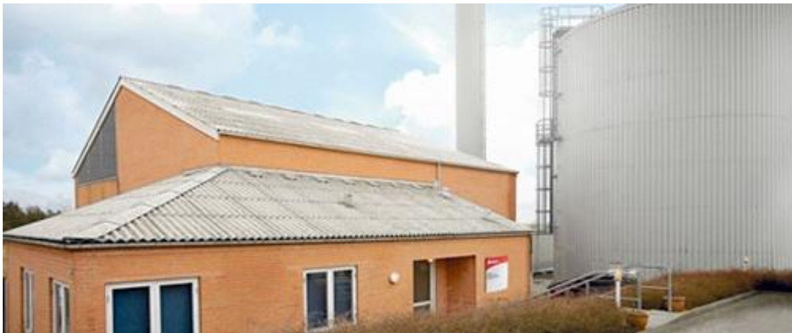
Figur 8-11 Ørslev Terslev Kraftvarmeværk
