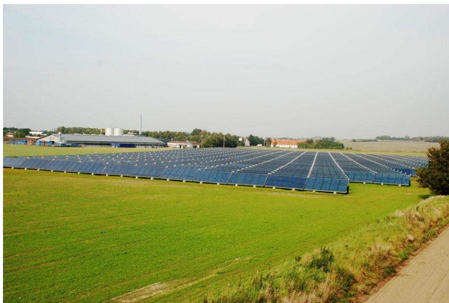
Figur 9-4 Jægerspris Kraftvarme med solvarme
